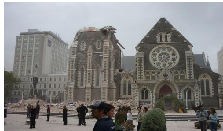
Zvonik crkve je teško oštećen, Christchurch, New Zealand, februar 2011.
